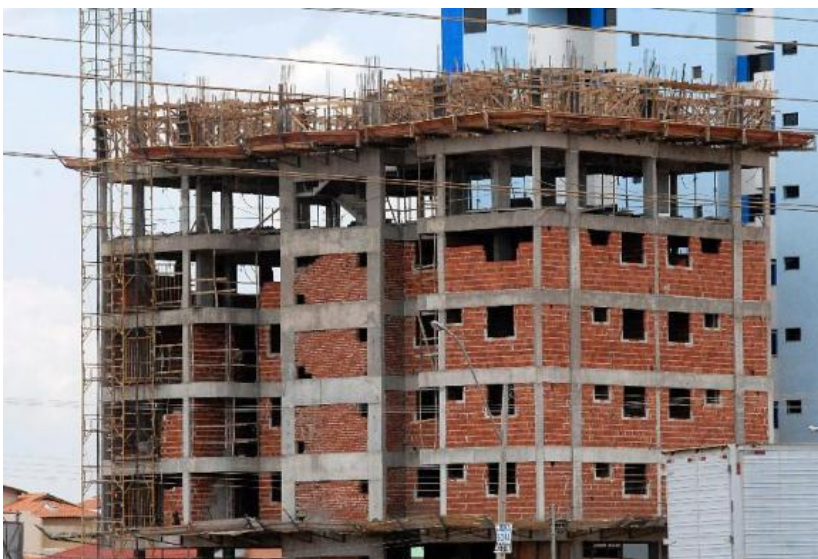
Fotografia 1 - Vista lateral do edifício
